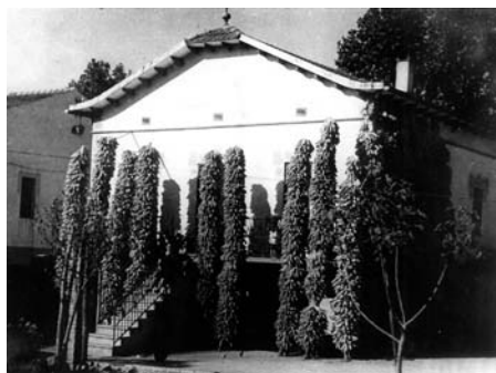
Figura 11. Façana d'una casa martorellenca "decorada" per les piles de moresc. Font: Arxiu Municipal de Martorelles
